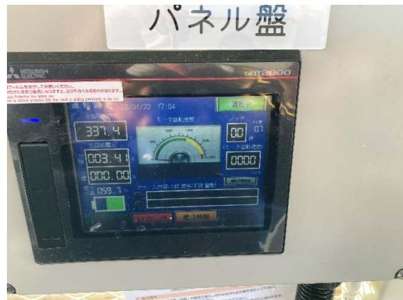
本製品は、日本製のリチウムイオンバッテリーを搭載し、エンジン型と比べても性能に差はなく、走行時も同等の能力（平坦最高速度 6.9km/h）を有しています。また、タッチパネルモニターには、モーターの回転数や設定段階、バッテリー状況が可視化されており、無駄のない操作や適切なタイミングでの充電が可能です。さらに電動化によって、排気ガス量をゼロにすることで坑内作業環境の改善をするとともに、ゼロエミッション及びカーボンニュートラルへの取り組みにも貢献いたします。
